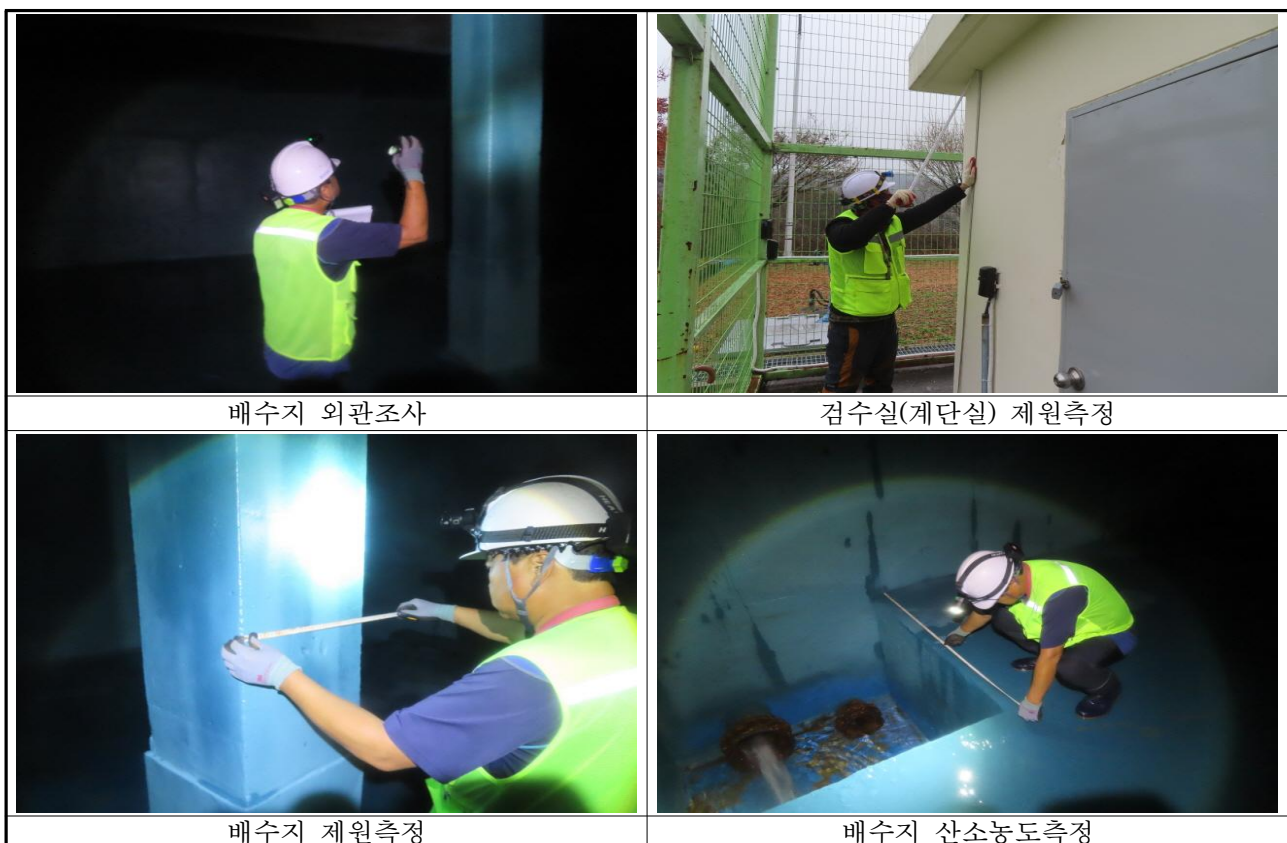
【사진 3.1】 시설물 외관조사
